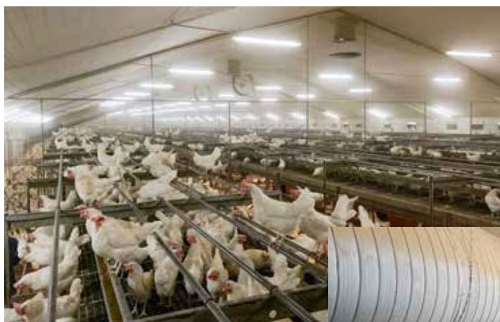
Luften från värmväxlaren blåses in mitt i stallet och fördelas med hjälp av en rad fläktar
